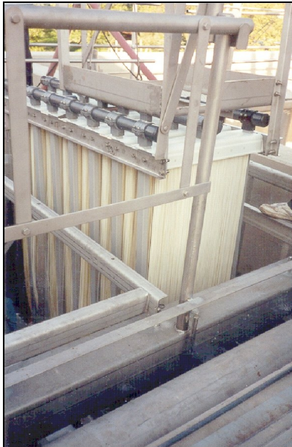
Abbildung 15a: getauchtes Membranmodul im Belebungsbecken
