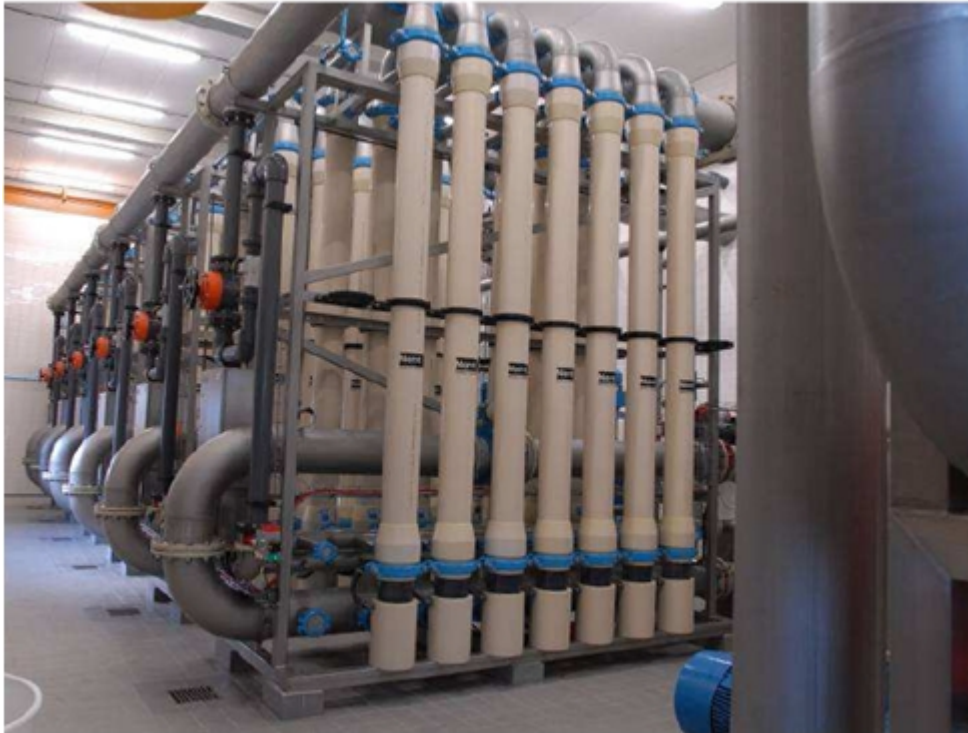
Abbildung 16: Beispiel eines extern trocken aufgestellten Membranmoduls (Röhrenmodul) für einen MBR (die Bauformen sind unterschiedlich)
