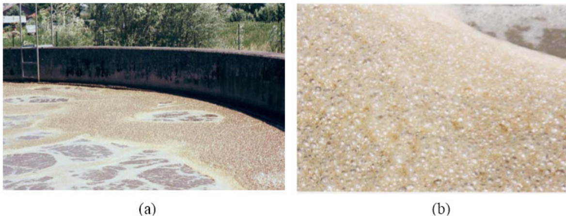
Abbildung 54: Schwimmschlamm auf Nachklärbecken: a) Übersicht; b) Nahaufnahme [PARIS, S. (2004)]
